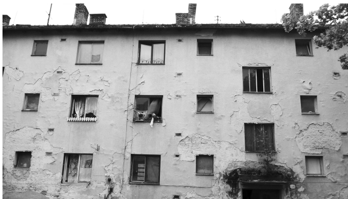
Obytný dom s opadanou omietkou, poškodenými komínmi i stromom nad vchodom a s bytmi v havarijnom stave, aj takto sa býva vo V. Krtiši.
